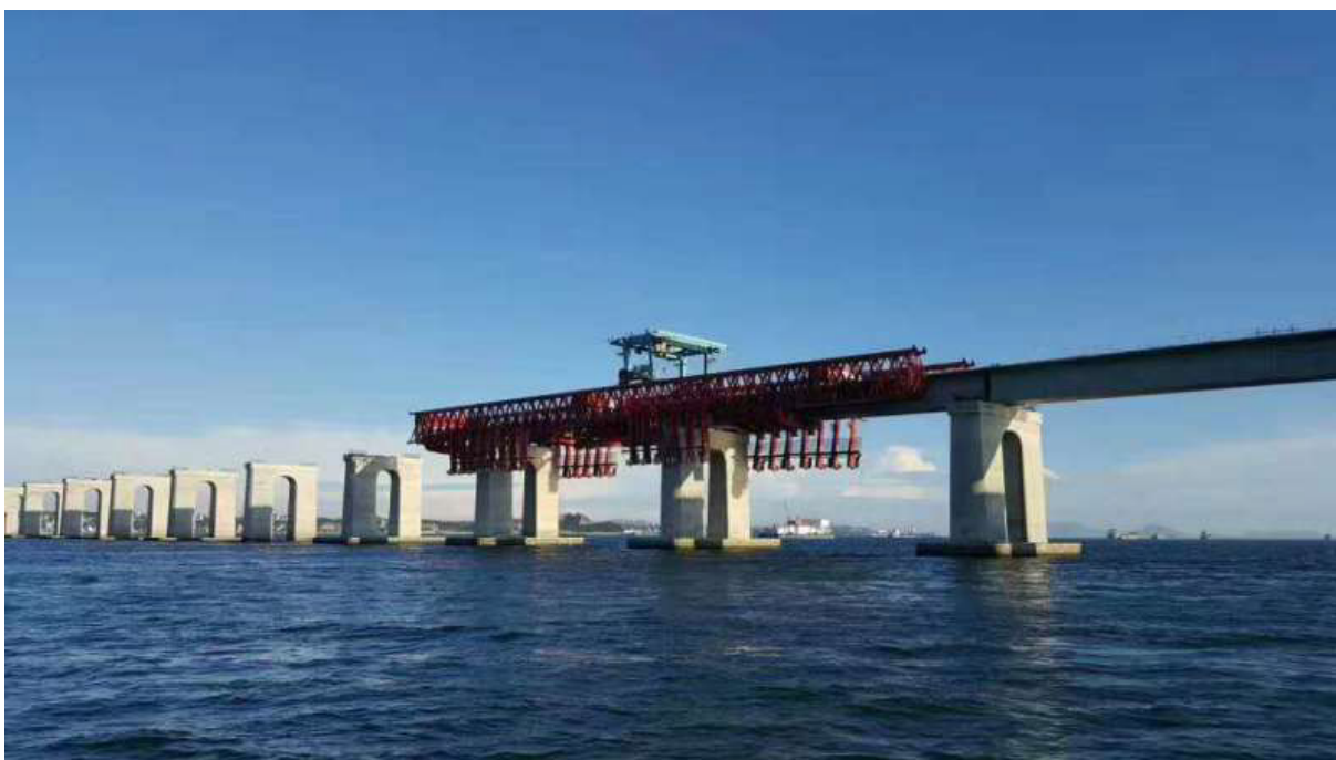
2700t 节段拼装造桥机
