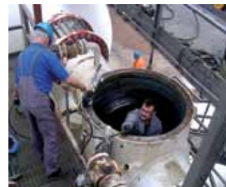
BORSIG Service GmbH Industrial Services 博希格服务公司 工业服务
